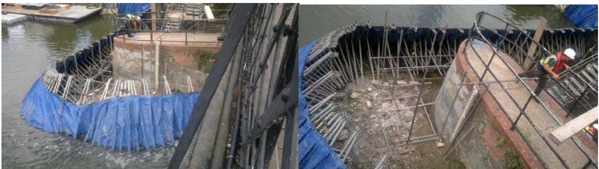
Figur 5. Tetningsduk lagt på et rammeverk av bygningsstillas fungerer utmerket som fangdam.
