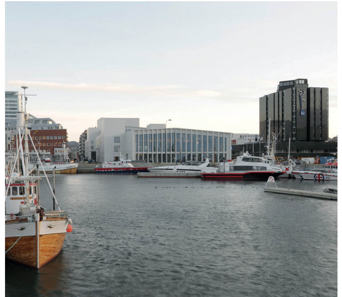
Stormen av DRDH. Bygningen har blitt en suksesshistorie, og er både lokalt og internasjonalt anerkjent. Foto: David Grandorge
