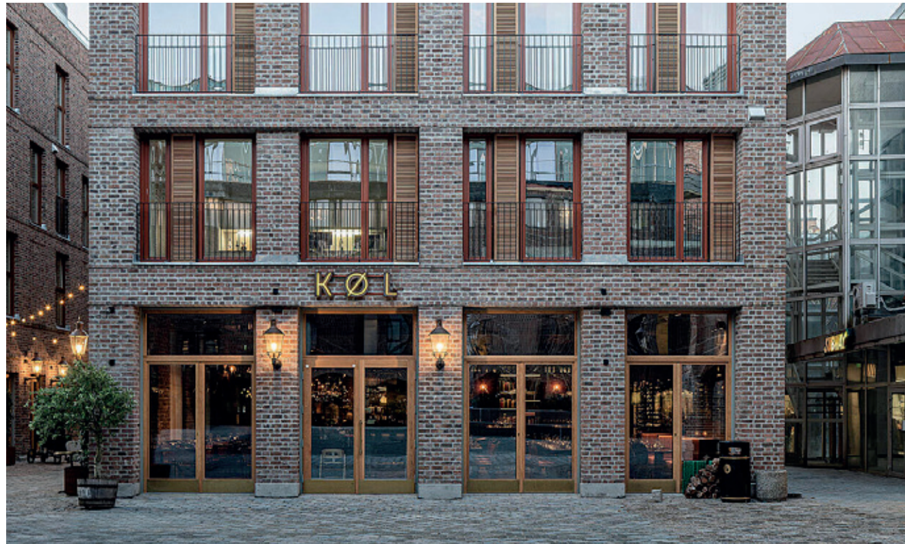
Nygårdsplassen i Fredrikstad. Variasjon i dybde på pilastre og vindusfelt, material og tekstur gir dybde. Foto: Kyrre Sundal
