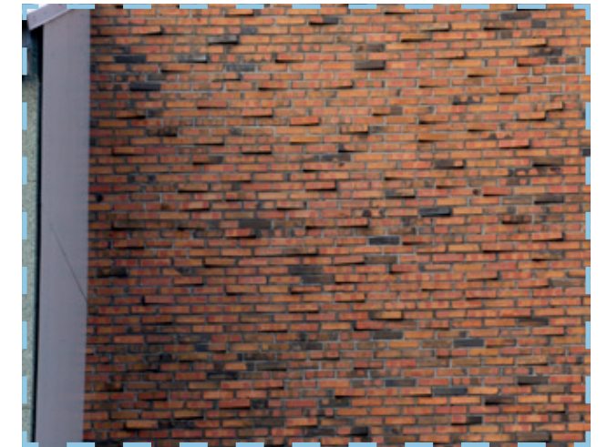
Storgata 27. Mursteinene stikker ut av veggen, som gir et rikt skyggespill.
