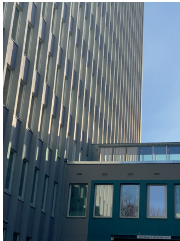
Skyggevirkning i vertikale pilastre på Sentralbygget på Gløshaugen.
