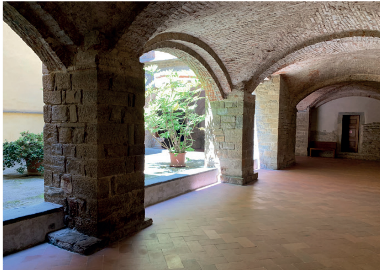
Bilde tatt i Firenze. På nært hold blir teglens tekstur, og arkitekturens oppbygging tydelig for oss på grunn av lysets egenskaper.
