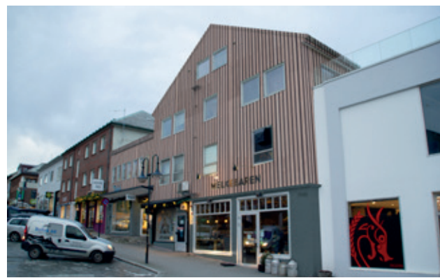
Trekledning med farget puss i 1. etg
