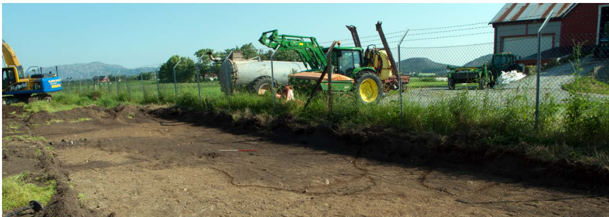
Figur 28. Rester av eldre dyrkingslag nylig avdekket lengst sørøst på Felt 3. Bildet er tatt mot nordøst (Da57587_275). Foto: Dag-Øyvind Engtrø, NTNU Vitenskapsmuseet.
