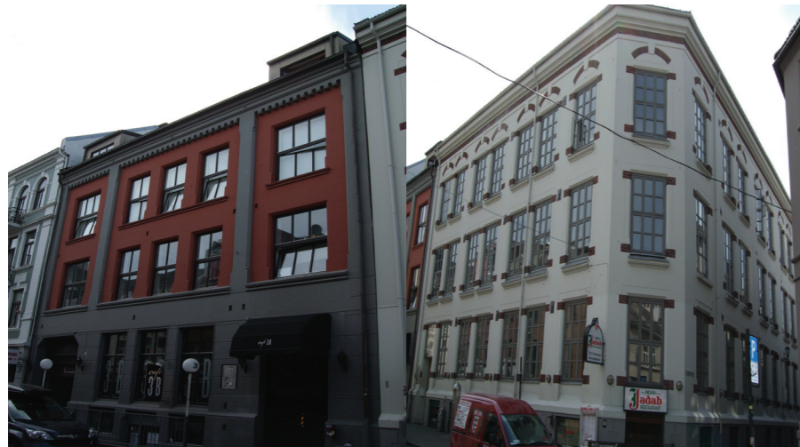
Til venstre Brattørgata 3B og til høyre Brattørgata 5 sett fra Brattørgata
