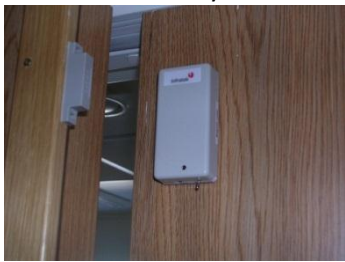
Bilde: Sensor og solenoidlås
