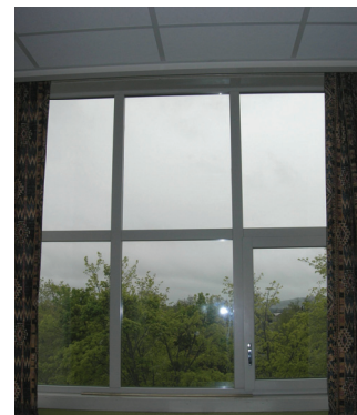
Figur 53: Nye vinduer mot sør
