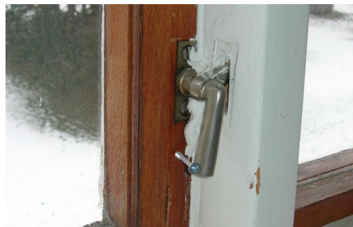
Figur 33: Isolerte vinduer hindrer varmetap
