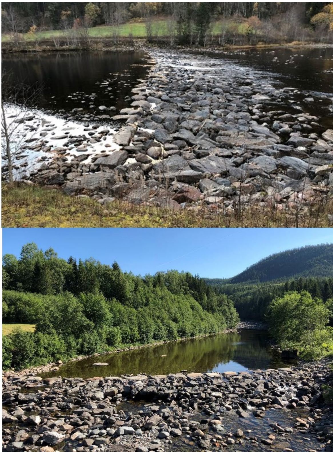
Bilde 7. Eksempler på terskler som er henholdsvis svært vanskelig (øvre bilde) eller nesten umulig (nedre bilde) å passere på typiske sommervannføringer. Foto: B. Köhler/NINA
