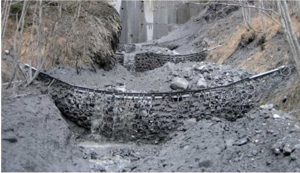
Figur 7: Fleksible ringnett brukt i sikring mot flomskred. Fotoet tilhører Geobrudd AG, og er hentet fra Håland, G., Langelid, A. (2015).
