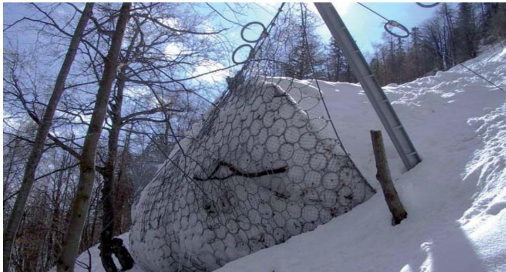
Figur 8: Fleksible ringnett brukt i sikring mot snøskred i et testområde i Fieberbrunn i Østerrike. Fotoet tilhører Geobrudd AG, og er hentet fra Håland, G., Langelid, A. (2015).
