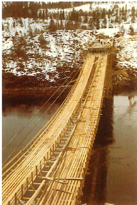
Figur 5.13: Arbeidsbru i hovudspenn (Vik, 1970a).
