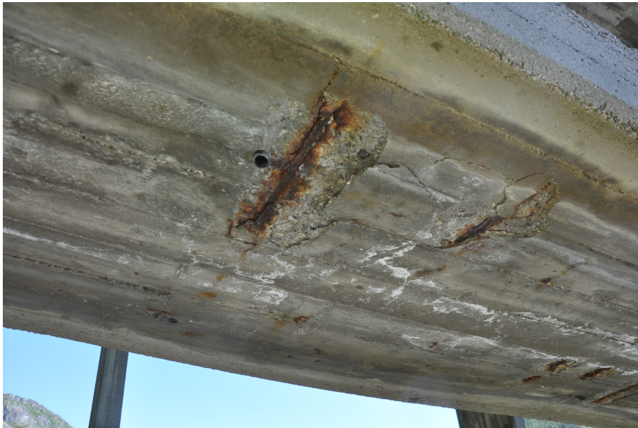
(a) Underkant av strekkband.
