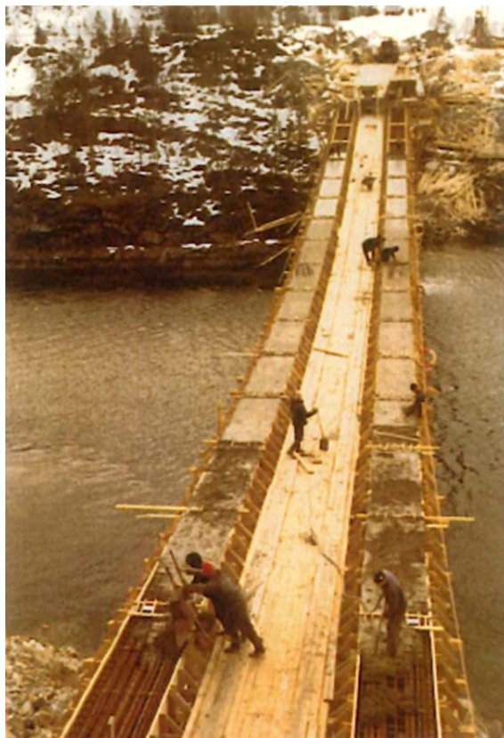
Figur 5.14: Støyping av strekkband (Vik, 1970a).
