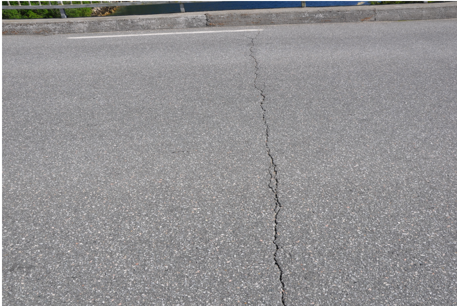
Figur 6.1: Tverrgåande riss ved akse 2 (Statens Vegvesen, 2021).
