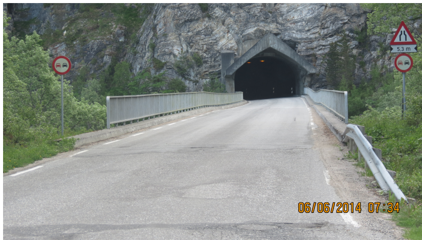
(b) Brubanen sett mot tunell.
