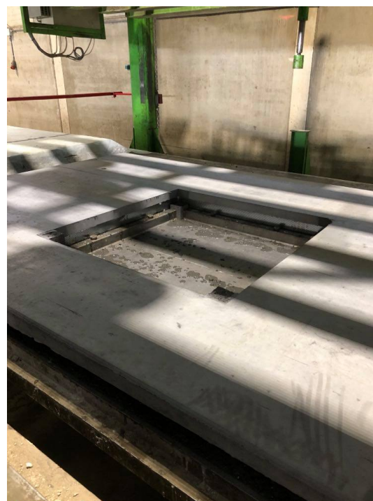
(c) Herdet betong ett døgn etter støp.
