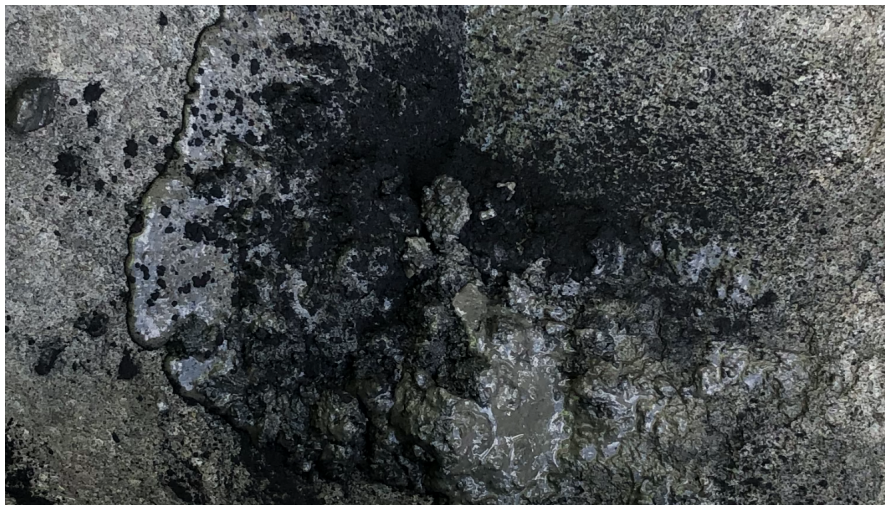
Bilde 13.5.1: Blandingen etter første uttak av første vangebetong. Bildet viser for lite tilsatt fukt og for dårlig blandet betong.
