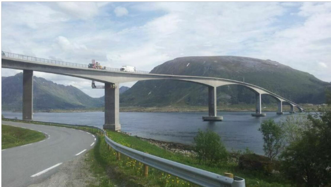
Figur 1.2 – Gimsøystraumen bro er et eksempel på ei fritt-frembygd betongbro med varierende bjelkehøyder. Foto: Statens Vegvesen
