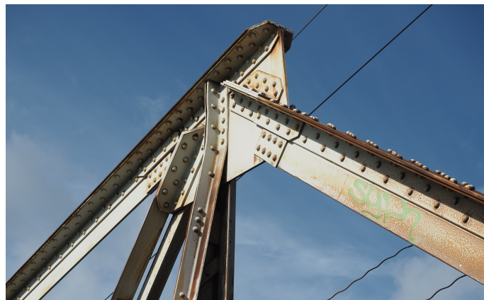
Figur 6: Eksempel på nagleforbindelser i Lerelva bru. [Foto: Gunnstein Frøseth, NTNU]
