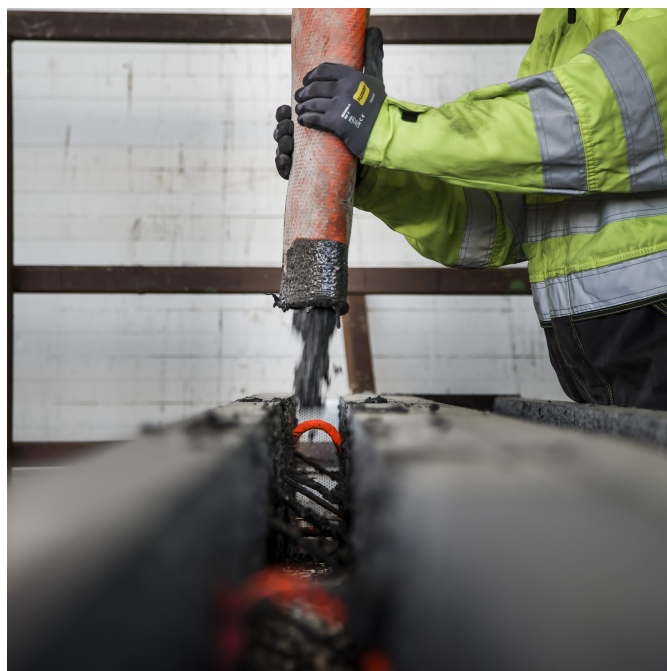
Bilde 13.5.3: Pumping av senterbetongen inn mellom vangene. Foto: Ketil Jacobsen og Snøhetta.
