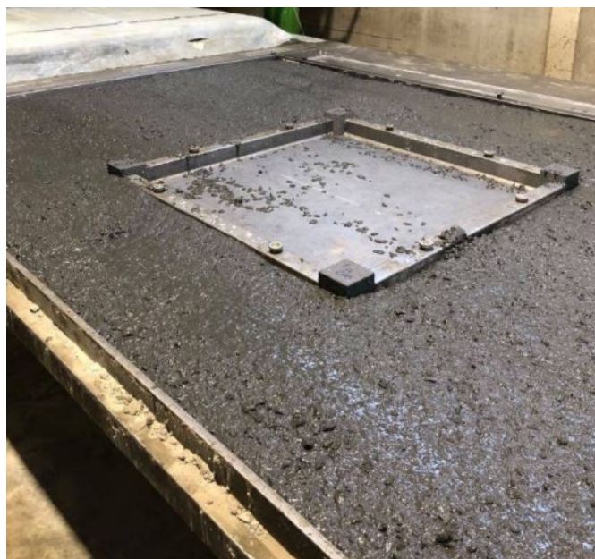
Bilde 12.2.2: Den ferske betongen i metallformen uten vibrasjon.
