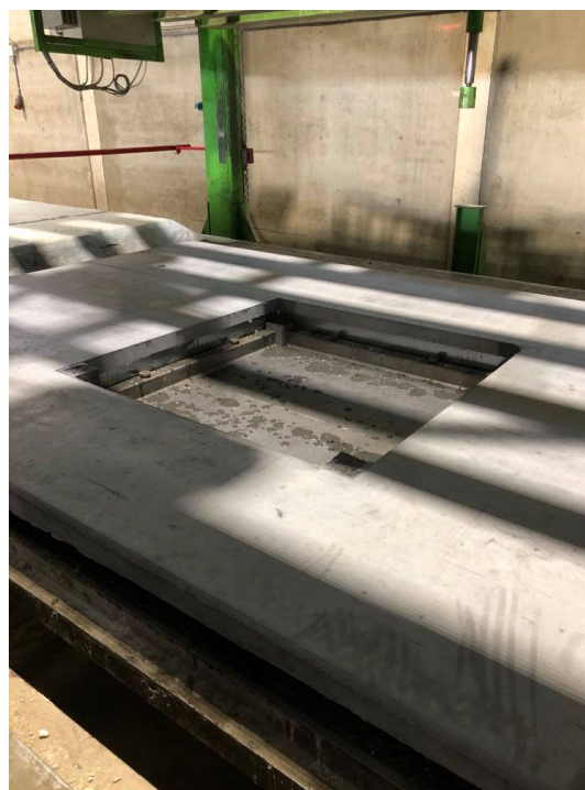
(c) Herdet betong ett døgn etter støp.
