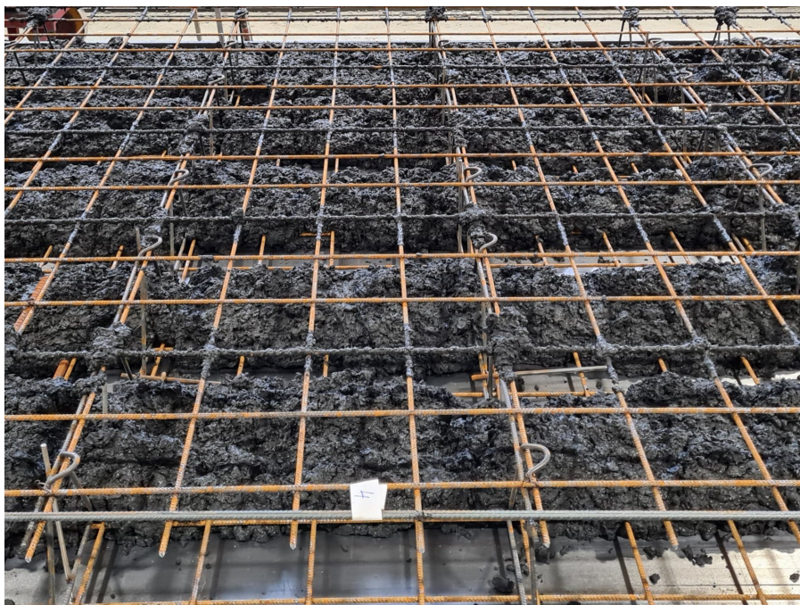
(a) Fersk betong før vibrasjon i metallformen.
