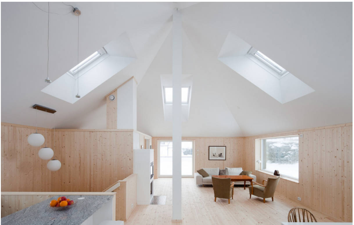
Figur 22: Takkonstruksjon med bæresøyle (Framtidens Aktivhus AS 2011a)
