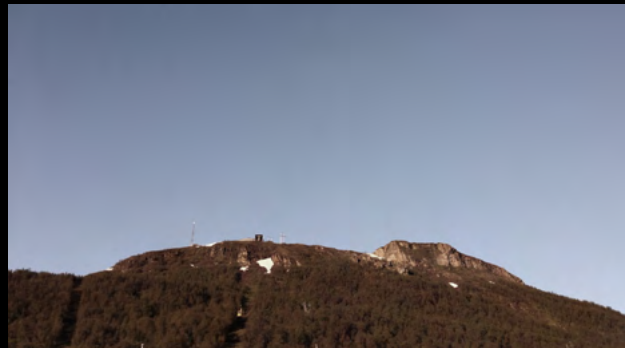
Øvre stasjon og Storsteinen sett fra nedre stasjon.
