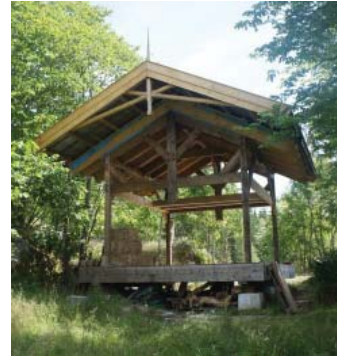
Slik ser byggverket ut nå, det er en indre bærende struktur av tømmer, tak med takstein og et golv som står på stabber. Grunnflaten er 20 kvm innvendig, 30 kvm utvendig. Denne veggen vil domineres av et stort vindu.
