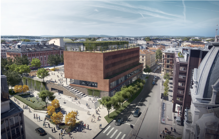
Figur 4.1: Ruseløkka skoleprosjekt. Bygges av Veidekke for Oslo kommune, (Hentet fra "Presentasjon taktplan Ruseløkka").
