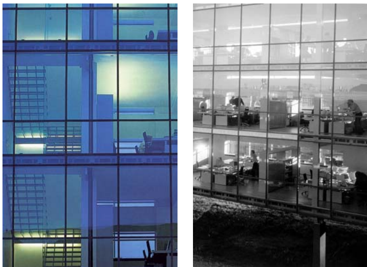
Figur 13. Nordfasaden til B&O sitt hovedkontor (1998) i Struer, Danmark får sitt arkitektoniske uttrykk i stor grad takket være fravær av ventilasjonskanaler og kunstig himling.
