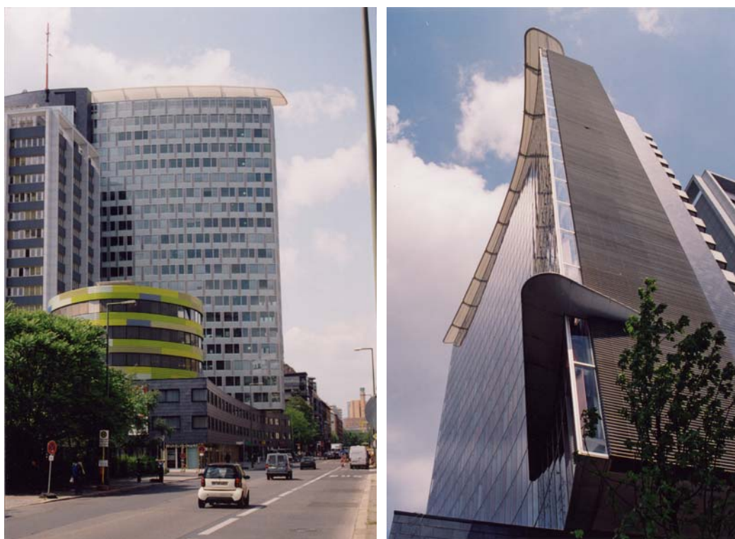
Figur 11. Øst fasaden til høy-huset til GSW's hovedkontor (1999) i Berlin, Tyskland er "perforert" med ventilasjonsåpninger for tilluft (venstre). Dette er et eksempel på lokale ventilasjonsåpninger, se side 51 for forklaring av begrep . Vest fasaden på samme bygning har en dobbeltfasade som bl.a. fungerer som avtrekk for ventilasjonslufta (høyre). Dette er et eksempel på et karakteristisk ventilasjonselement for naturlig ventilasjon som påvirker arkitekturen.
