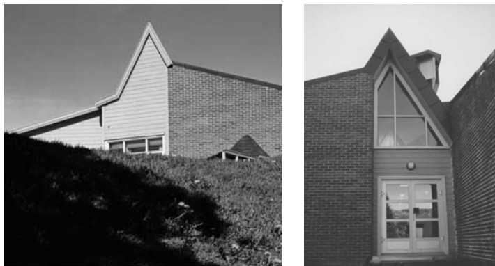
Figur 14. Takformen på Grong barneskole (1998) på Grong, Norge understøtter den naturlige luftsirkulasjonen der varm og forurenset inneluft trekkes ut gjennom det høyeste punktet i taket. Taket bidrar i så måte på å gi skolen sin noe uvanlige silhuett.
