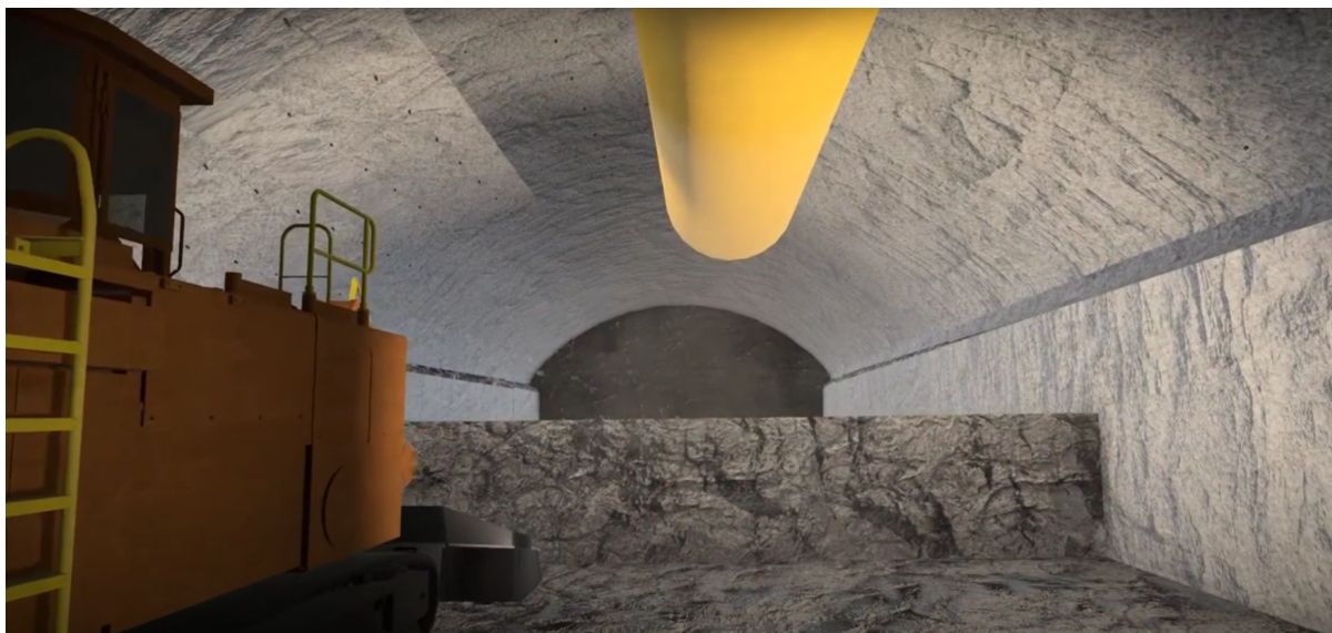
Figur 6.5: Illustrasjon av prinsippet med ”benching-metoden” på West Connex M4-M5 Link (West Connex, 2021). ”Benken” må ha en jevn stigning for at roadheaderen skal komme til i øvre del av tverrsnittet.
