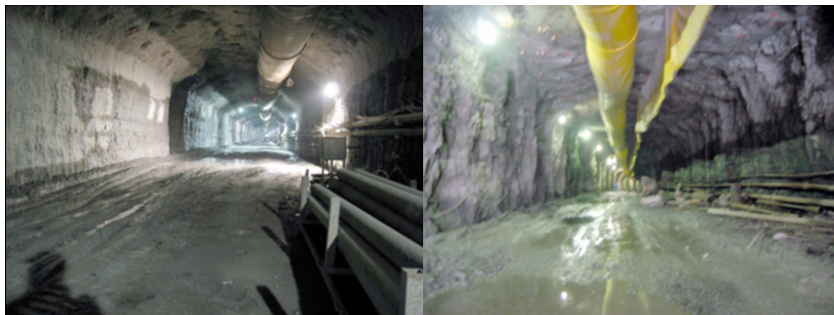
Figur 6.7: Forskjell i konturkvalitet mellom roadheader (venstre) og D&B (høyre) på Montreal Metro (Restner og Reumueller, 2004).
