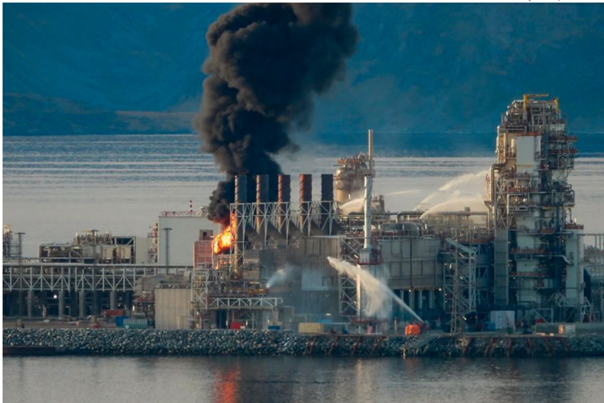
Figur 4.3: Anlegget på Melkøya
