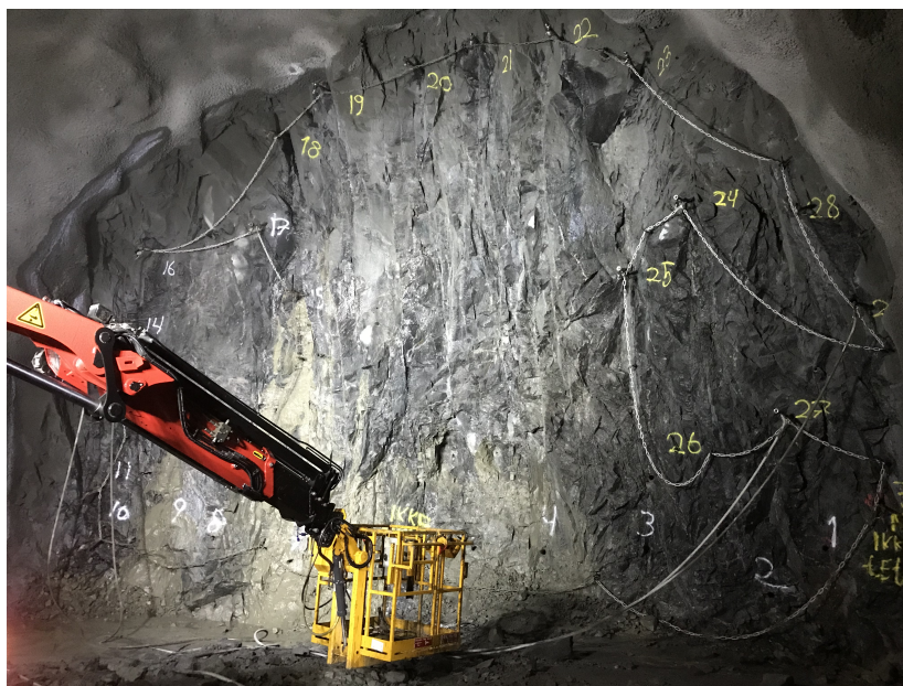
Figur 2.1: Slik ser stoffen ut under forinjeksjon. Hvert nummer har en tilhørende stav og stag, som sement pumpes inn i (Foto: Privat, med tillatelse fra entreprenør)
