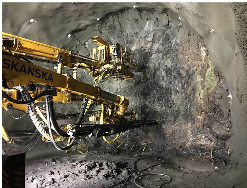
Figur 2.2: Slik ser stoffen ut under salveboring. Her kan man se at stoffen er sikret med bolter og sprøytebetong langs hele tverrsnittet av tunnelen (Foto: Privat, med tillatelse fra entreprenør)
