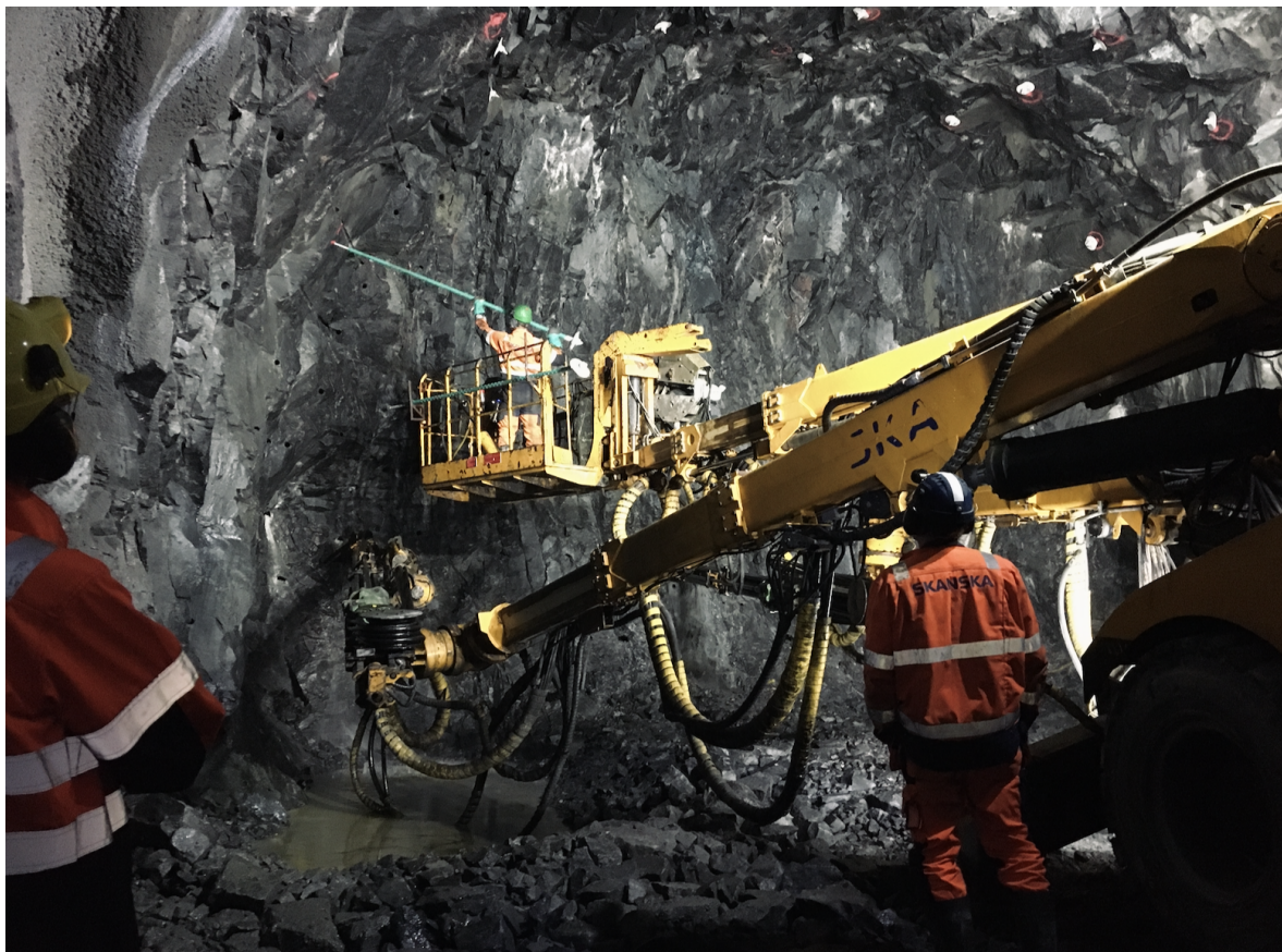
Figur 2.5: Slik ser stoffen ut under samtidig bolting og salveboring. (Foto: Privat, med tillatelse fra entreprenør)
