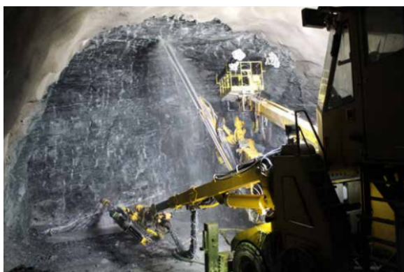
Figur 1.4: Salve og bolteboring. Foto: (Skanska Norge) (NFF, 2016)
