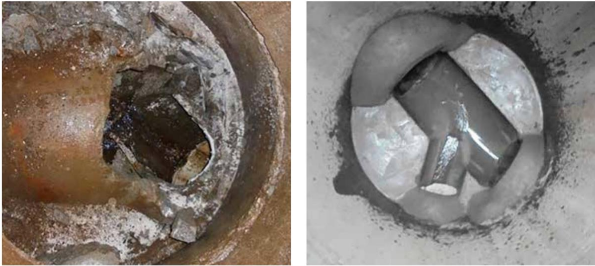
Figur 6: Kum før og etter fornying ved støping av ny bunn. (Olimb, 2015, s. 62)
