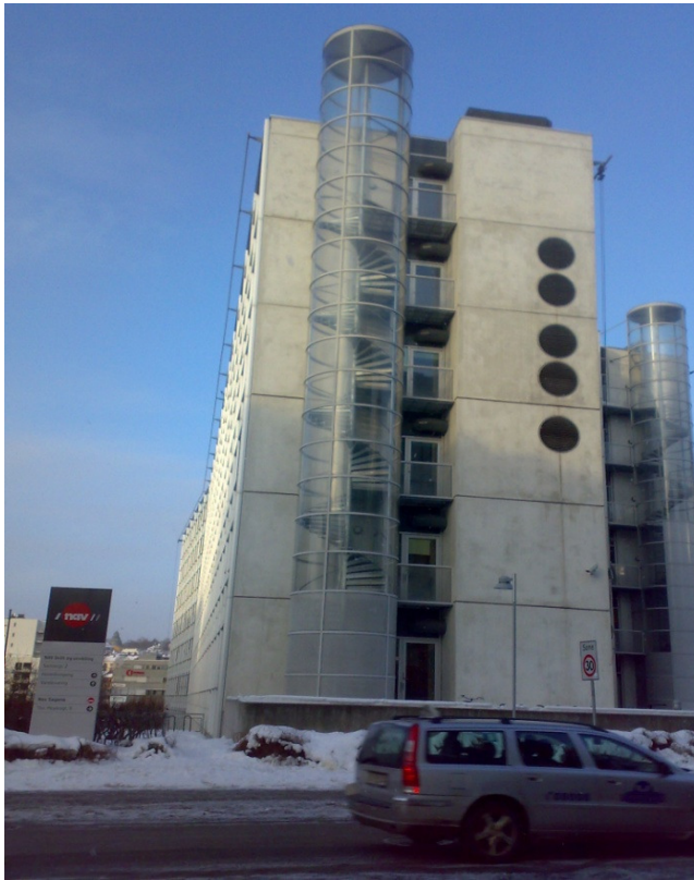
Bilde: 12 - Rømning via vindeltrapp
