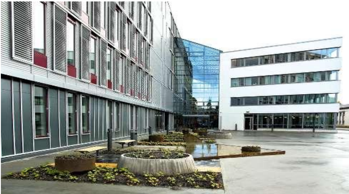
Bilde av byggets fasade med begge blokkene og glassgården i midten
