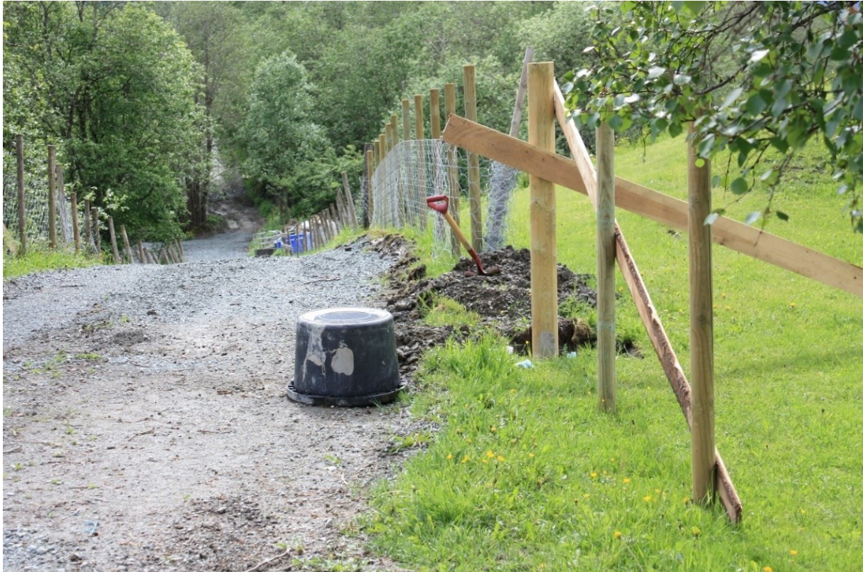
Bilde 16. Arbeidet med å sette opp hagegjerd med nedslåtte staur. Hagen er til høyre i bildet, der hvor det så vidt synes grener av et bjørketre. I bunnen av veien som ses på bildet renner elva forbi (Foto: Tommy Ruud, 8. juni 2020).
