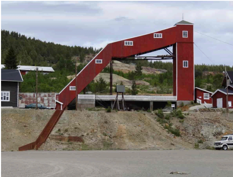
Figur 2.3: Bildet viser Hovedgruva i Folldal (8).
