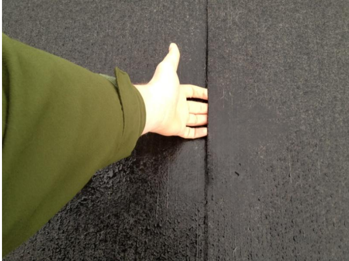
Bilde 5 - Hull i takpapp
