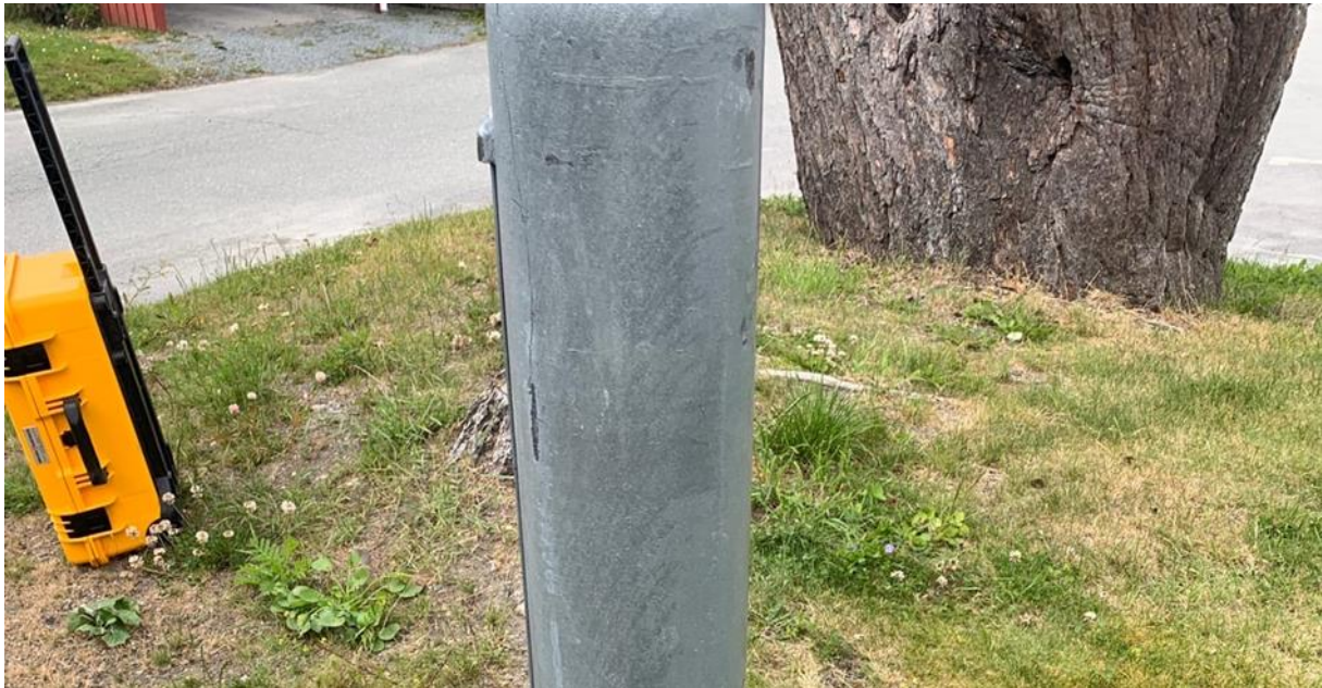
Figur 29. Masten #24, Møllebakken. Det mørkende området er et synlig bevis for påvirkning av erosjon.
