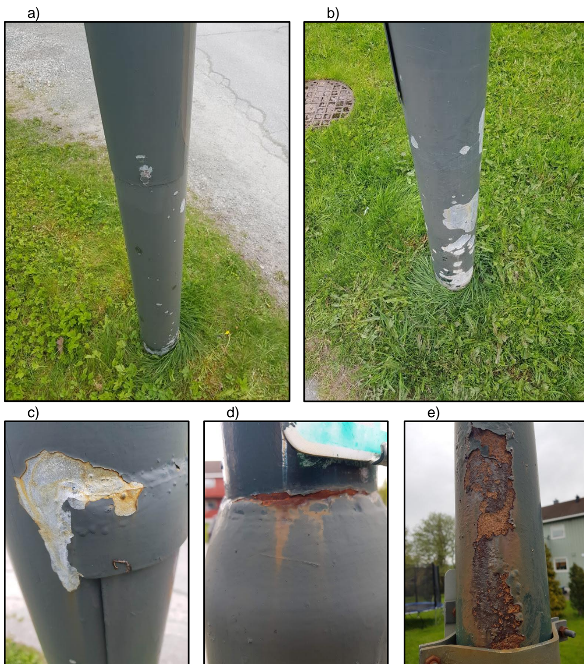
Figur 37 – Bildene a-e er alle av mast C2, men viser en representerende tilstand blant de andre mastene C4 og C5 på området. Bilde a og b viser et oversiktsbilde for nedre del av masten, og bilde c viser et detaljbilde av dekkelet og området rundt. Bilde d viser innsnevringen i masten, og hvordan det er tegn til korrosjon. Bilde e viser tydelige forekomster av korrosjon, og er tatt av mastens øvre del.
