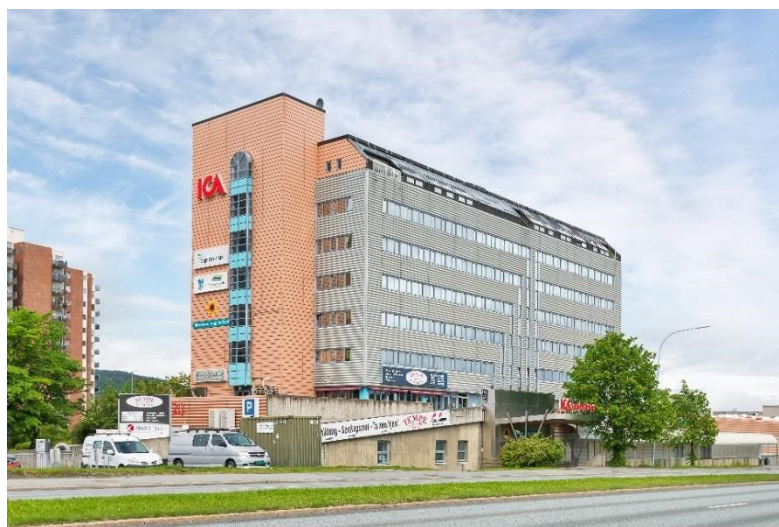
Figur 4.1: MAX-bygget før totalrenovering. Hentet fra Syltern (2019)
