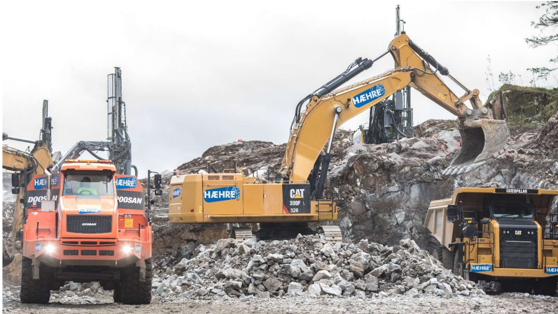
Bilde 1: Masseflytting (Hæhre Entreprenør)
