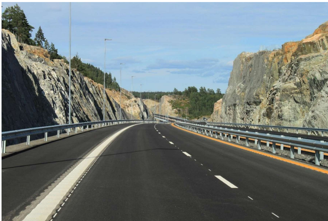
Bilde 6: Ferdig vei (Hæhre Entreprenør)
