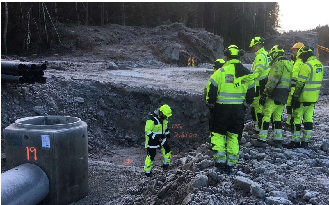
Bilde 2: Befaring rådgiver og entreprenør (Hæhre Entreprenør)
