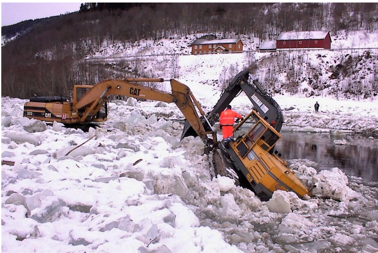
Figur 25 Fjerning av ispropper med gravemaskiner innebærer ofte risiko. I dette tilfellet gikk det bra med de involverte, men bildet illustrerer risikoen fjerning av ispropper innebærer. Bildet er ikke ifra overnevnte hendelse. Foto Knut Aune Høseth/NVE (Norges Vassdrag- og energidirektorat, Ingen dato)
