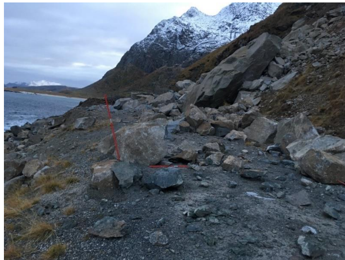
Figur 22 Bilde av et ras på Myrlandsveien. Dette er veien representanten i Statens Vegvesen Lofoten snakket om i intervjuet (Ragnhild Lie, 2017).
