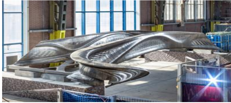
Figur 2 3D-printet metall bru
