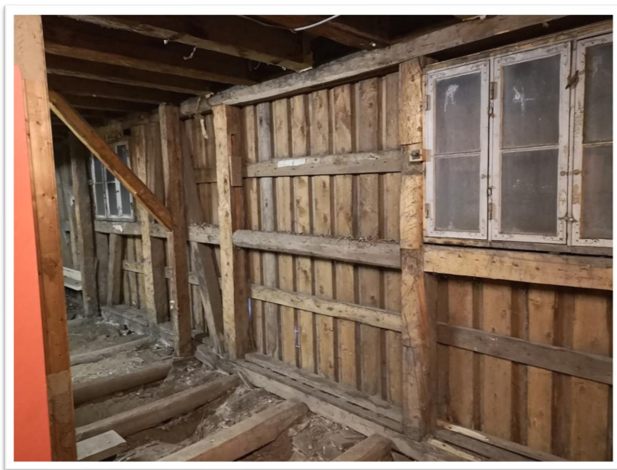
Figur 20 Bilder fra rom 10 og 11 hvor innerpanelet og noe av gulvet er revet. Foto: privat
