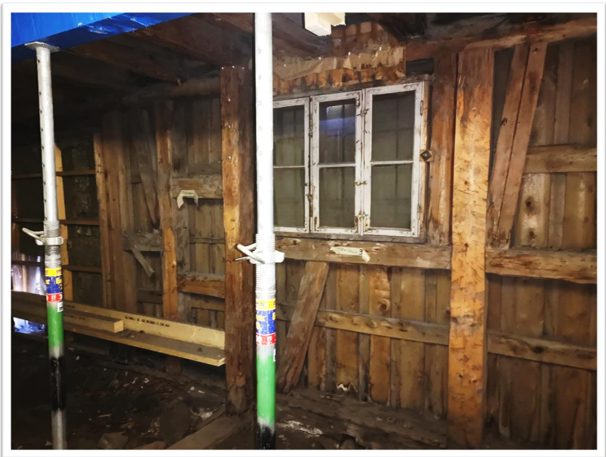
Figur 10 Bilde fra rom 10, innerpanelet er tatt av. Foto: privat
