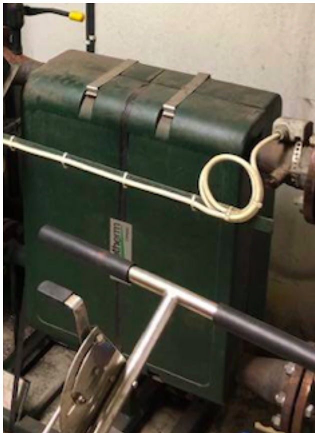
Figur 2.2: Varmeveksler til B.H. Modell: Cetepac. Produsent: Cetetherm. (Bilde tatt av Magnus Nilsen med tillatelse fra B.H.)
