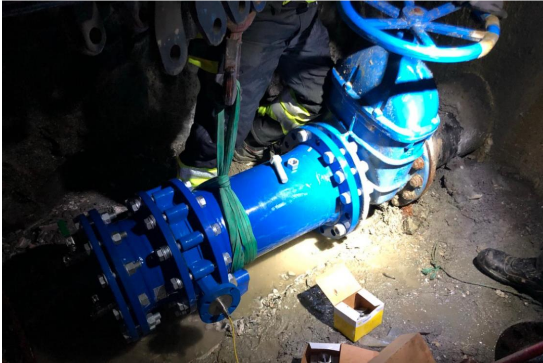
Figur 4.23: Montering av kammeret til sluseventil
