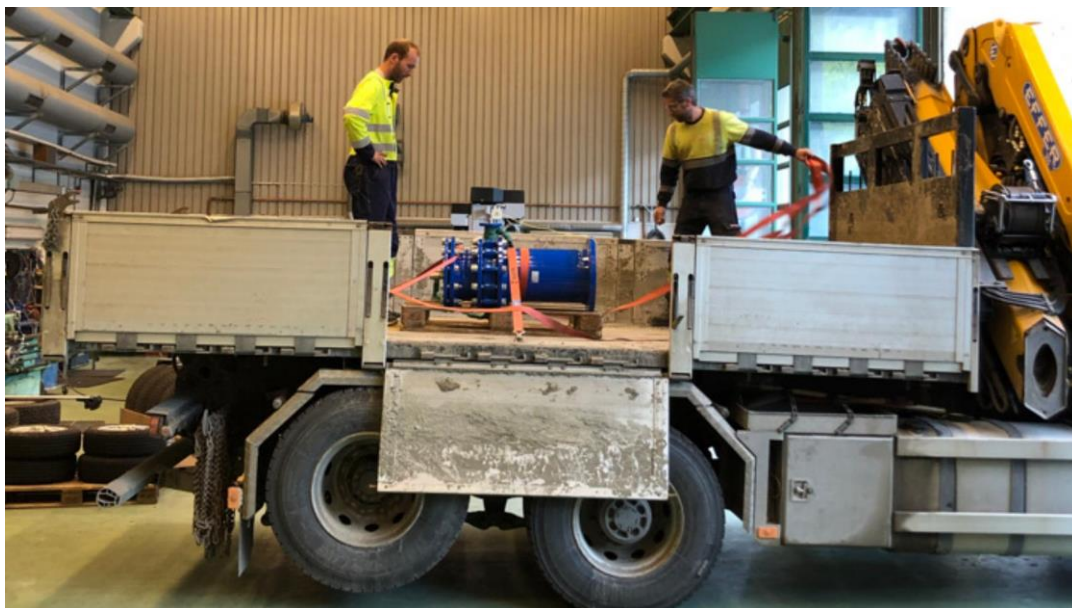
Figur 4.21: Sikring av kammeret på lastebil
