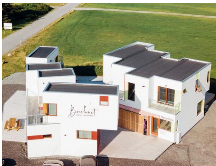
Figur 63 Bore Surf Hostel etter ferdigstillelse (Helen & Hard, 2018)
