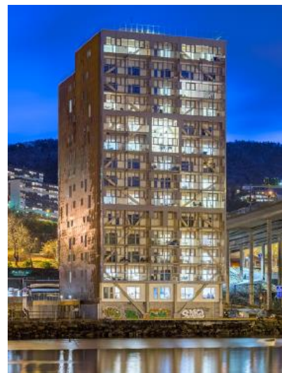
Figur 57 Treet i Bergen har et ytre bæresystem i limtre hvor det for hver femte etasje er konstruert en plattform. Hver plattform kan bærer lasten av fem nye moduler (Arctec, 2018)
