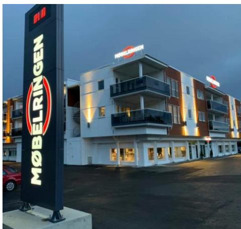
Figur 7 Byporten Harstad med næringslokale i første etasje og påbygg med moduler over to etasjer (Byporten, 2019)
