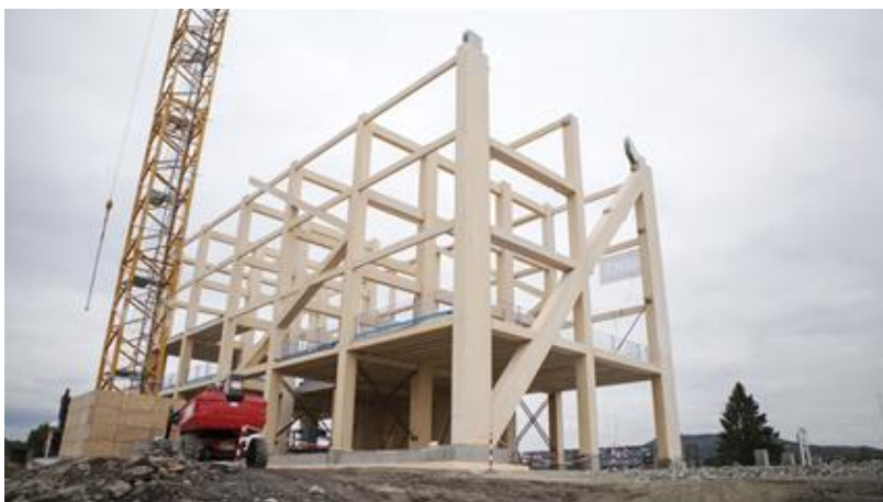
Figur 4 Bære- og avstivningssystemet i limtre er godt synlig i de tidlige byggefasene av Mjøstårnet (Solberg, 2017)
