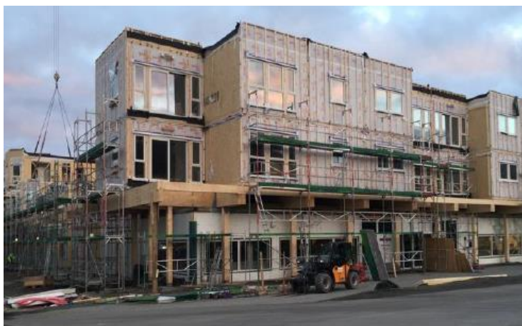
Figur 8 Byporten Harstad under montering av moduler. Limtreramme er synlig under og i forkant (Bunkholt, 2019)
