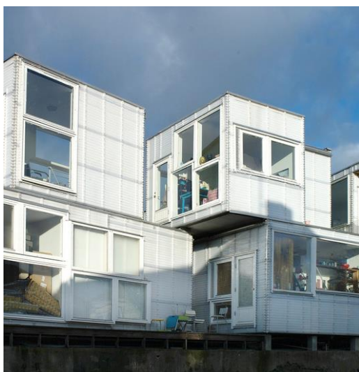
Figur 62 Gjenbruk av moduler på Bore Surf Hostel før flytting av modulene fra Stavanger (Helen & Hard, 2018)
