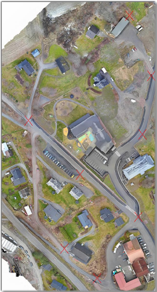
Figur 18: GCP i terrenget.
