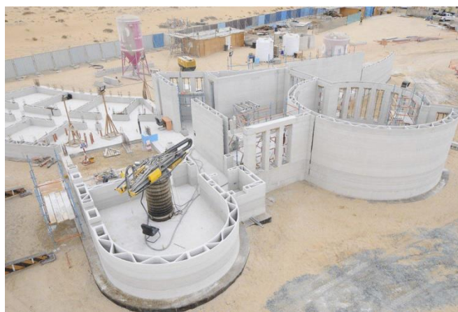
Figur 20: Oppføring av to-etajers kontorbygg i Dubai (Zeiba, 2019)
