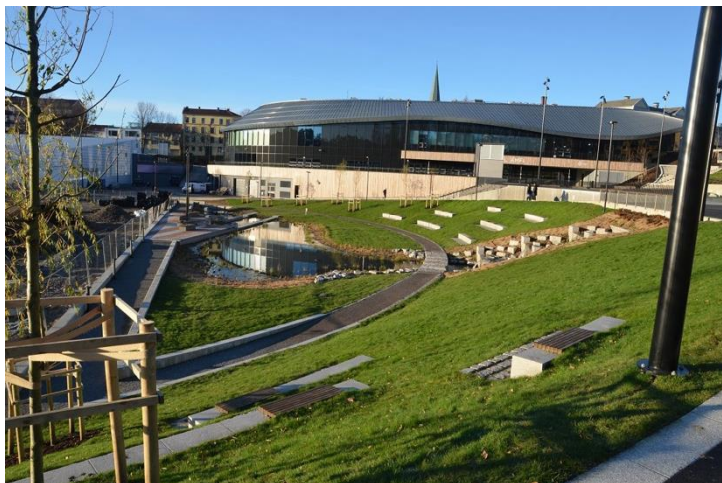
Figur 2-10 Utforming av amfi som et fordrøyningsanlegg (71)
