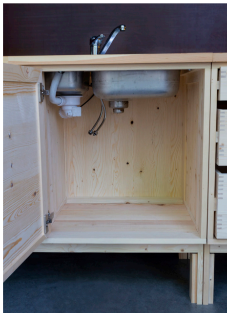
Skap under vask. Plass til avløpsrør og søppelemnt
