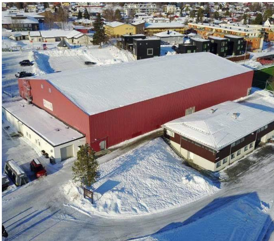
Figur 1.1: Bilde av Dalgård Ishall. Kilde: ishallitrondheim.no
