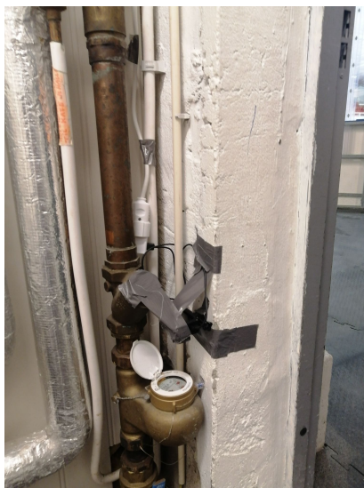
Figur 3.1: Overvåking av hovedvannmåler ved Dalgård
