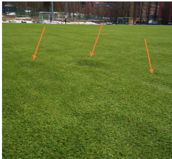
Bilde 11 Dumper i baneoverflaten
