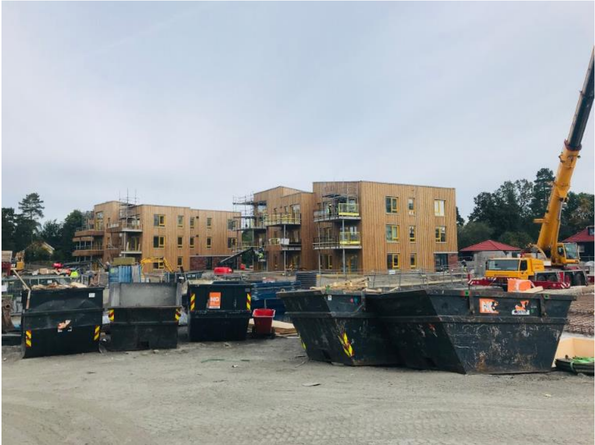
Figur 13: Befaring av avfallsstasjon.
