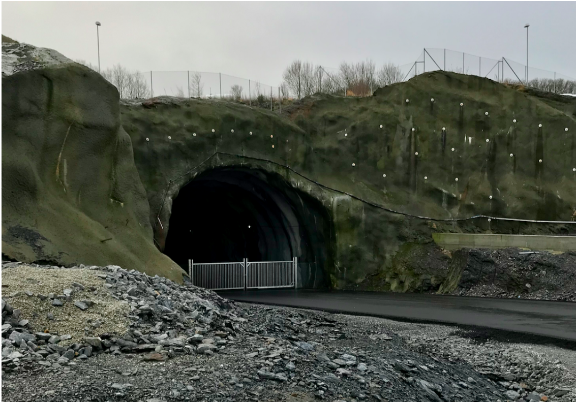
Figur 6.1: Inngangen til sidetunnelen på Mekjarvik som ble befart.
