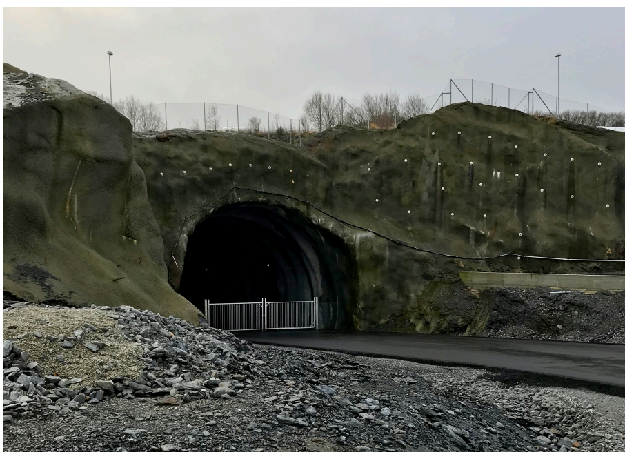
Inngangspartiet til sidetunnelen på Mekjarvik. Foto: Marie Hernæs Larsen.
