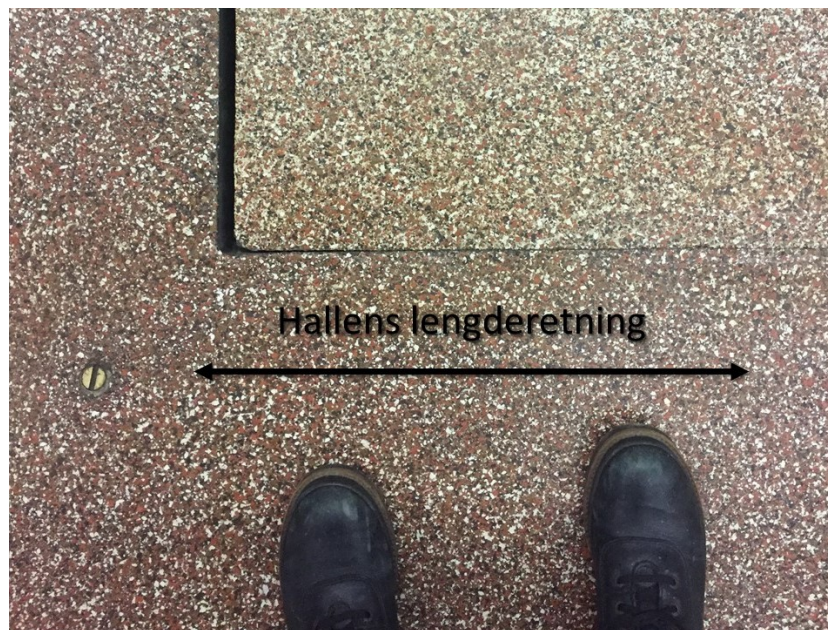
Figur 5.2: Hjørne til en av gulvlukene i maskinsalen. Avstanden mellom luken og åpningen er tydelig mindre langs hallretningen, som tyder på konvergens mellom langsideveggene. Bildet er noe misvisende da avstanden på motsatt side (utenfor bildet) er større. Foto: Ingrid Gulbrandsen, 24.02.2020.
