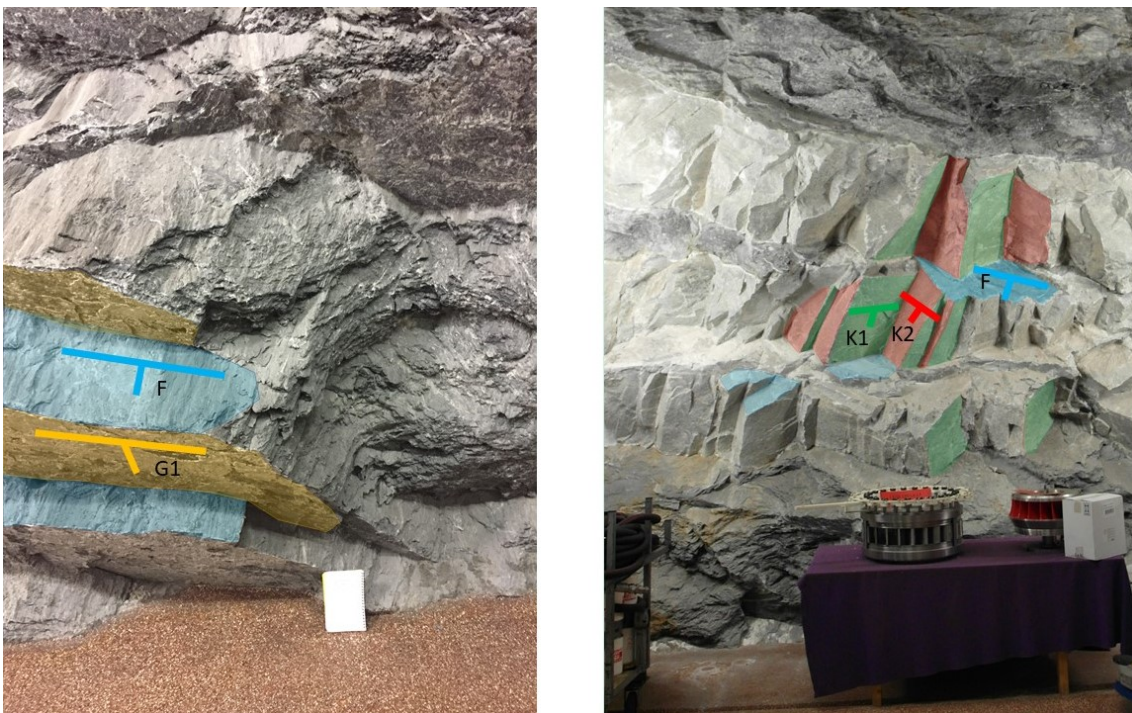
Figur 4.2: Opptredende sprekkesett i grafittglimmerskifer (venstre) og kvartskeratofyr (høyre). Begge bilder er tatt mot nedstrøms vegg. Foto: Ingrid Gulbrandsen, 24.02.2020.
