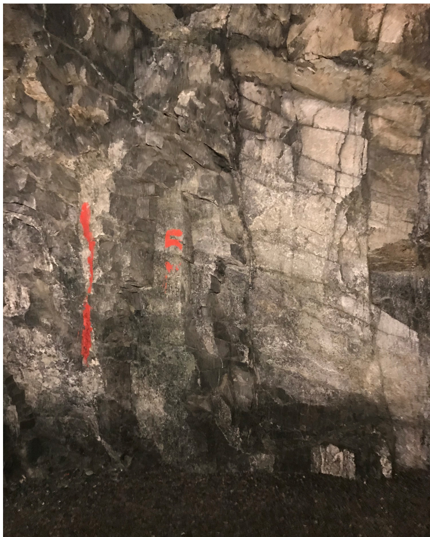
Figur 6.6: Avbildning av kalkspatmarmoren ved PEL490. Bildet er tatt opp til ca. 2 m høyde langs tunnelveggen.
