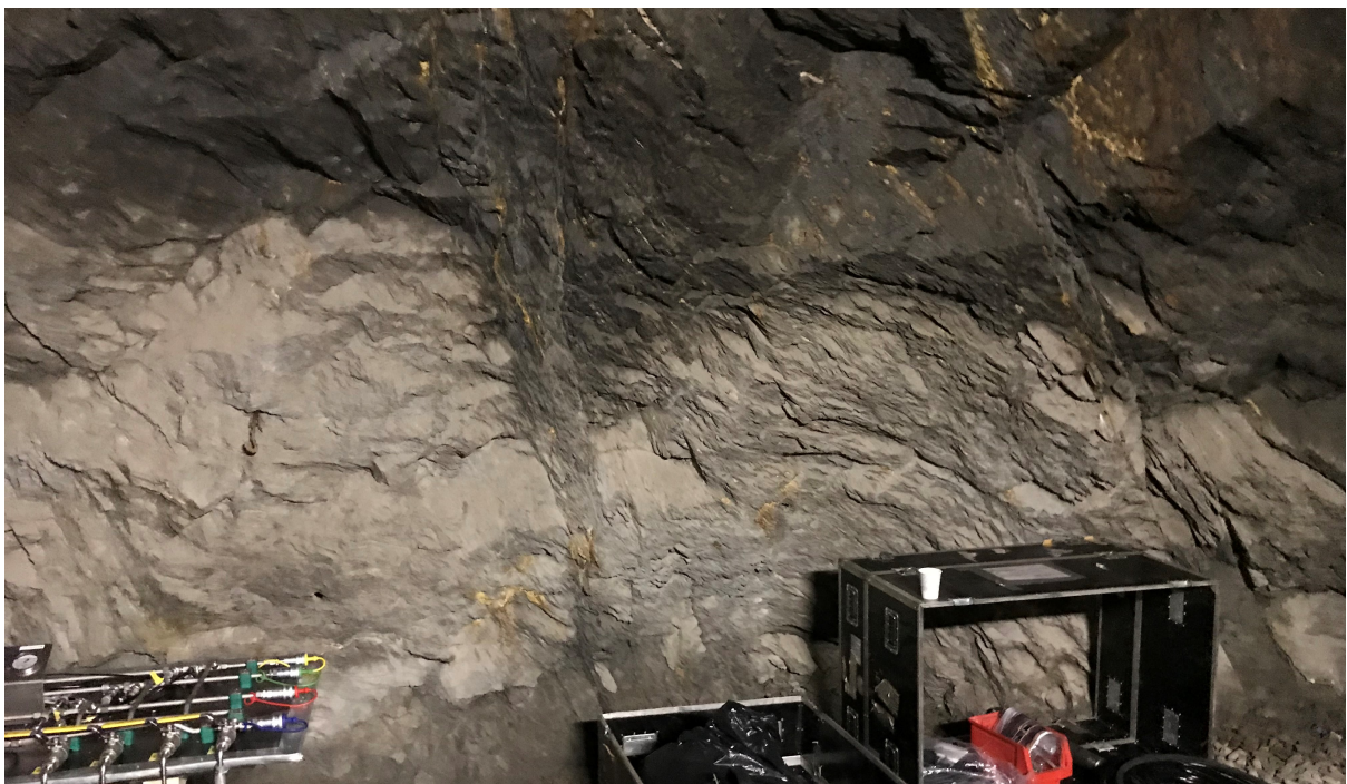
Figur 5.3: Bilde av bergmassen ved pel 80, som viser oppsprekking langs foliasjonen. I tillegg er det vist noe kjemiske utfellinger som trolig har oppstått etter tunnelen har blitt drevet.
