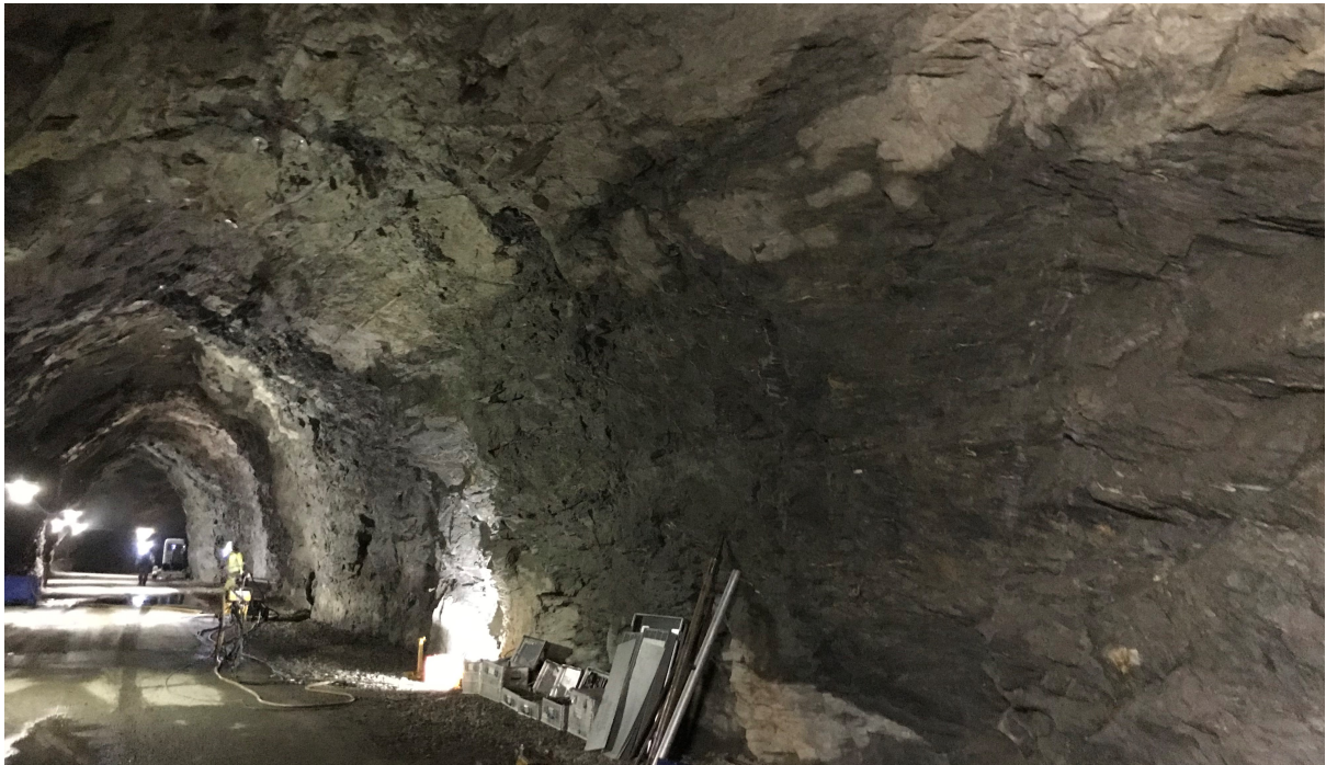
Figur 5.2: Bilde av bergmassen i måleområdet, ca. mellom pel 77 og 104. Bergmassen bestod av fyllitt, med svært inhomogene egenskaper.
