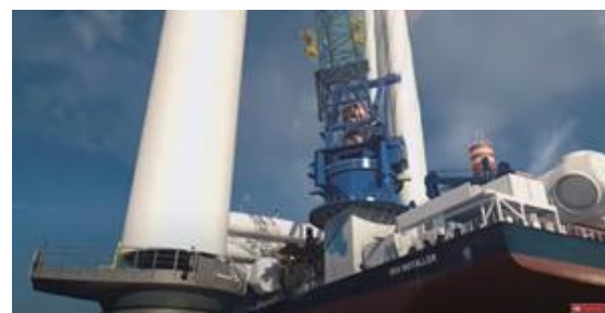
(d) Installation of turbine tower
