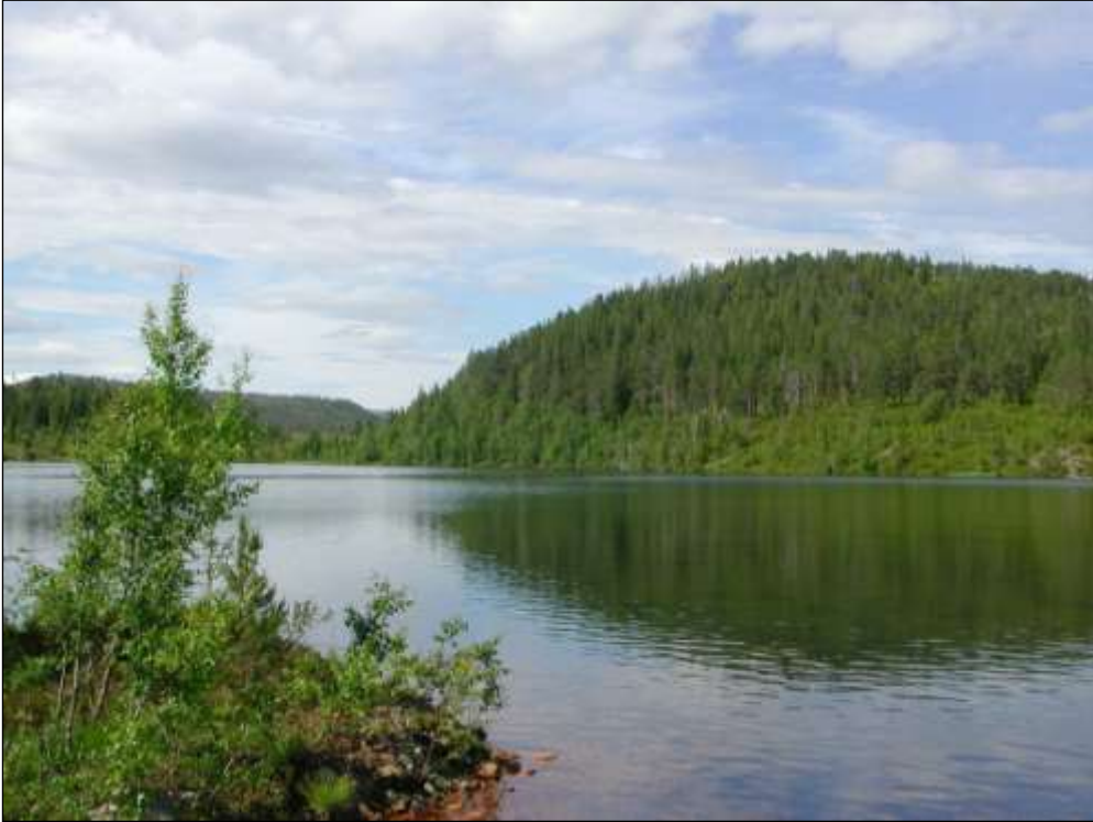
Bjønndalsdammen sett fra damkronen. Foto: Maria Thornhill, NTNU, 2003.
