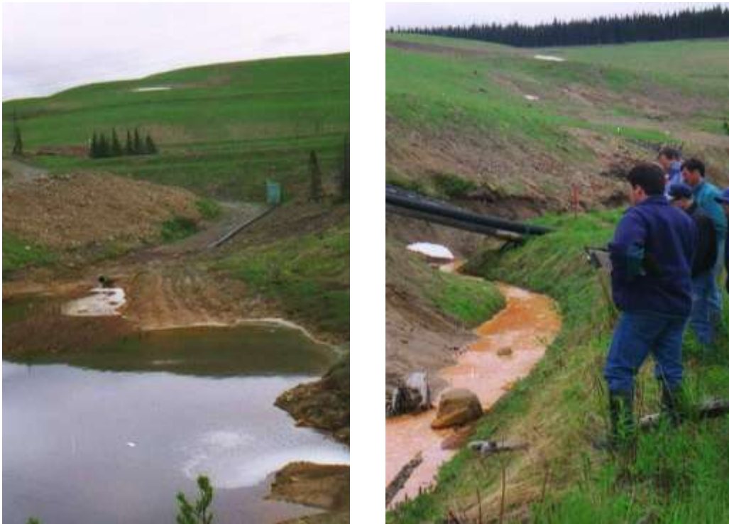
Den overdekkede gråbergtippen med oppsamling av sigevann (Equility Silver Mine, B.C., Canada).
