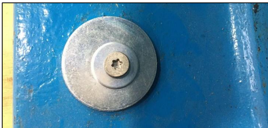
Figur 3-7 Innfesting av massetrinn 1 med treskrue gjennom bunnflensen til stålbjelken. Legg merke til skivene som øker skruhodets areal.
